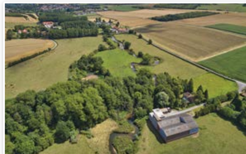
Reméandrage naturel suite à l'effacement de l'ouvrage du moulin de Guémy à Tournehem-sur-la-Hem.
