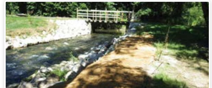
Vue vers l'amont de la rampe aménagée sur le bras droit, après travaux
