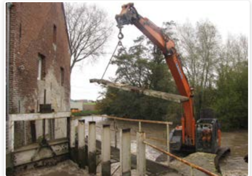
Démantèlement des vannes en cours de travaux
