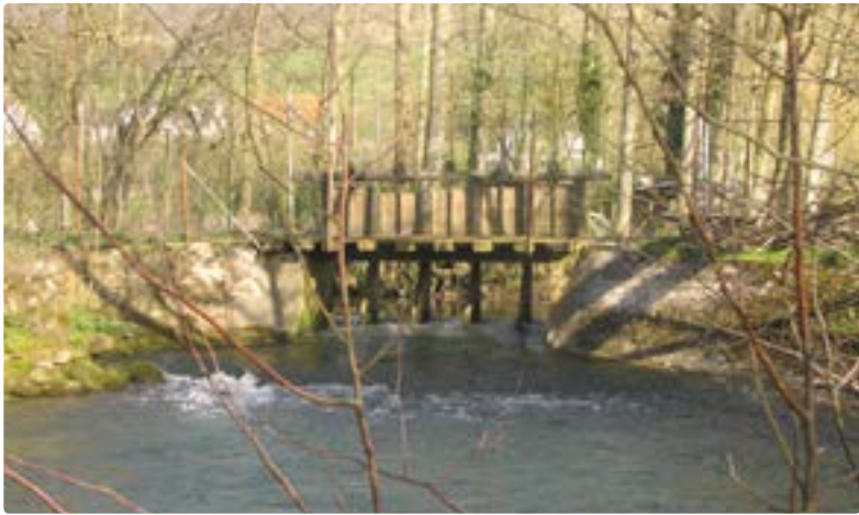
Vue de l'ouvrage du bras droit vers l'amont, avant travaux
