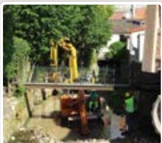
Pelle sans cabine qui travaille sous la passerelle (Aquatec)
