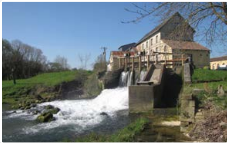
Ouvrage de la minoterie de Recques-sur-Hem avant travaux
