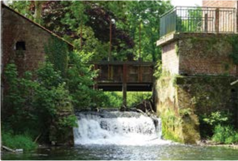
Ouvrage du bras droit avant travaux
