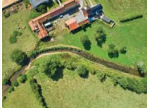
Photo aérienne après travaux (Vincent Hanotin).
