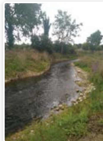
Nouveau tracé après travaux, vu vers l'amont
