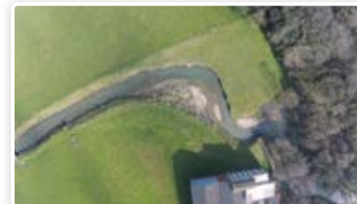
Photo aérienne de 2016, 2 ans après les travaux (FDAAPPMA62)
