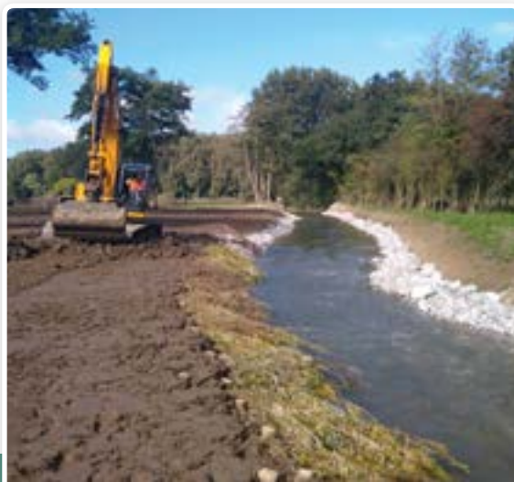
Vue du nouveau tracé vers l'amont
