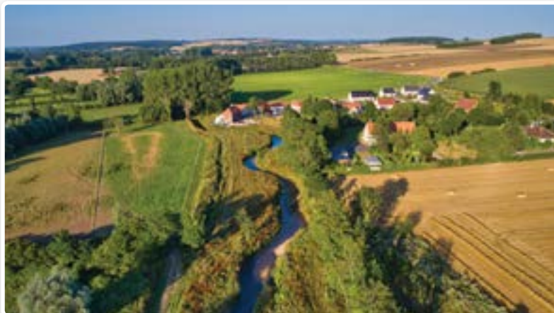
Photo aérienne de l'ensemble du nouveau tracé après travaux (Vincent Hanotin)
