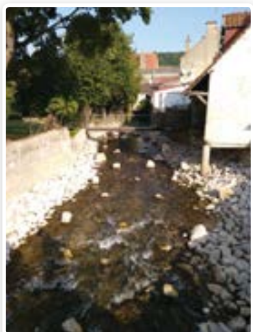
Rampe en enrochement sur le bras gauche après travaux
