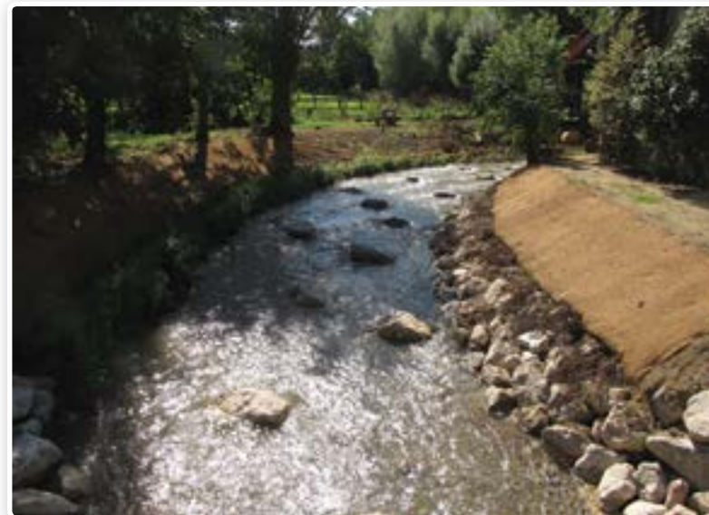
Vue du bras droit vers l'amont après travaux
