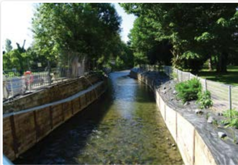
Protection de berges avec des parois berlinoises en amont de l'ouvrage
