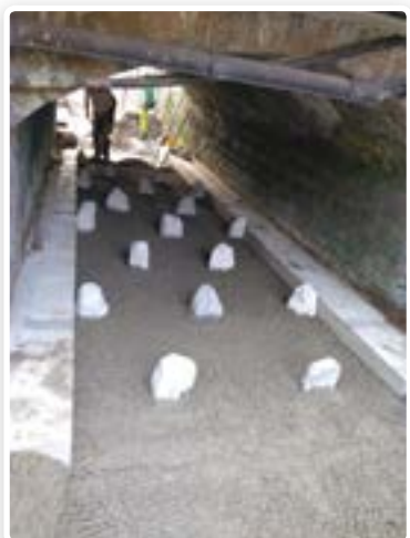
Échancre aménagée sous le pont de la départementale
