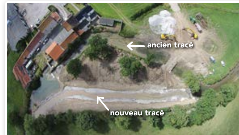
Photo aérienne de situation travaux en cours (FDAAPPM62)
