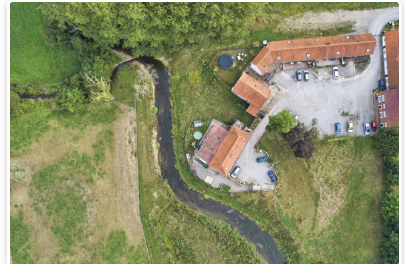
Photo aérienne après travaux (Vincent Hanotin)
