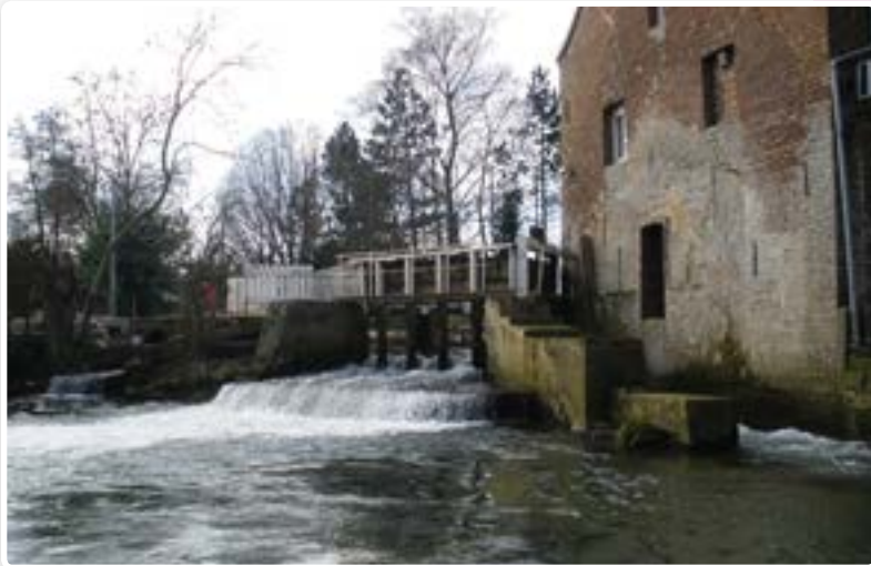
Ouvrage du Moulin bleu avant travaux
