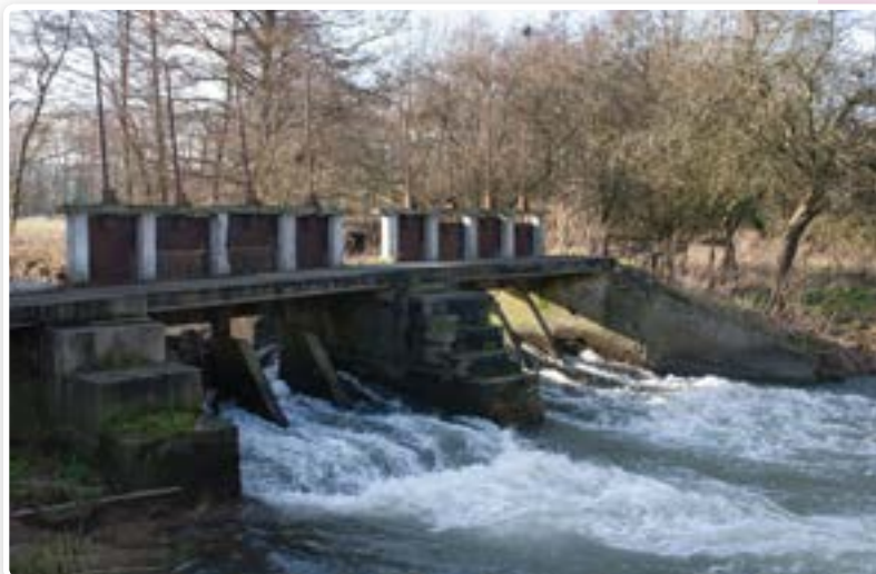
Ouvrage du moulin Vandroy avant travaux
