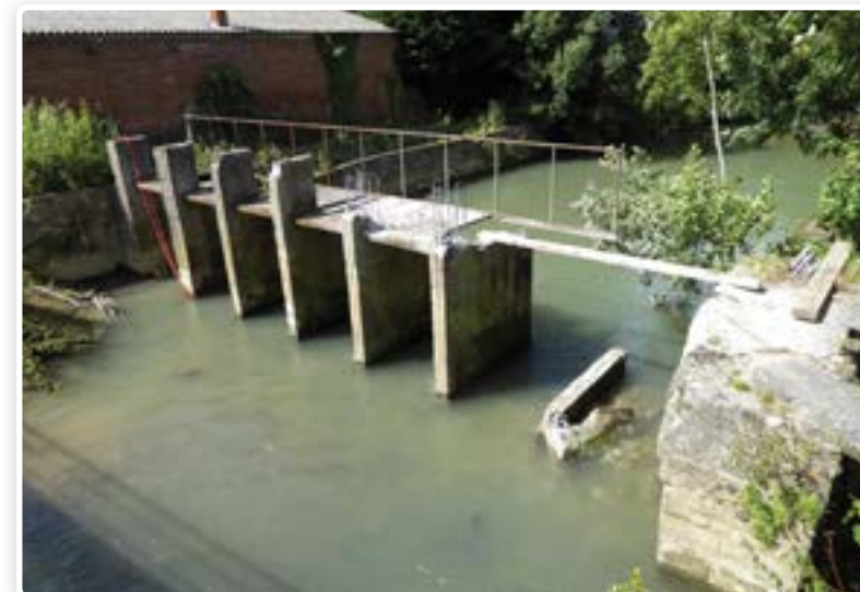
Démontage de l'ouvrage en cours de travaux (photo FDAAPPMA62)
