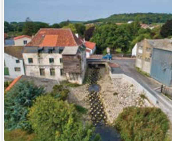
Vue aérienne de la rampe du bras droit après travaux (Vincent Hanotin)
