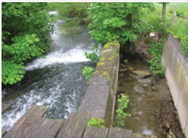
Ouvrage du bras droit avant travaux
