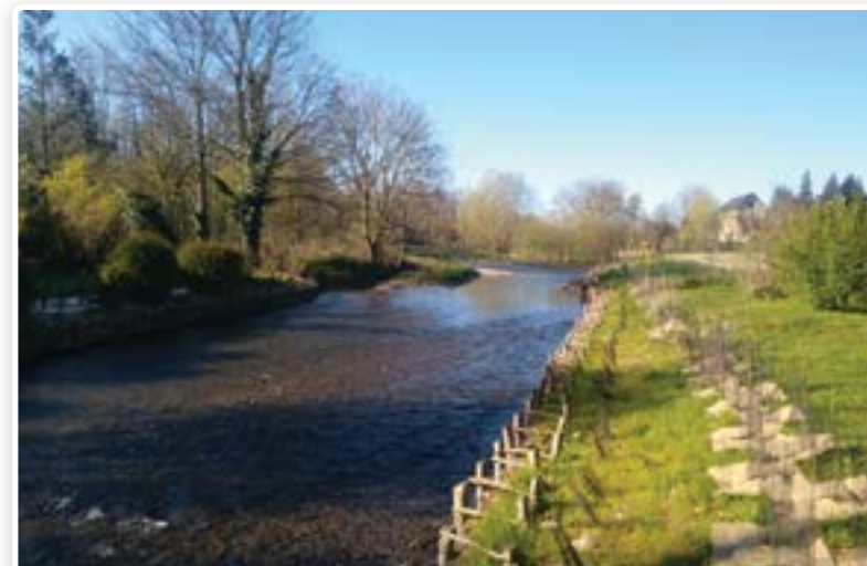
Protection de berge en génie végétal* réalisée en amont du pont rue basse à Recques-sur-Hem
