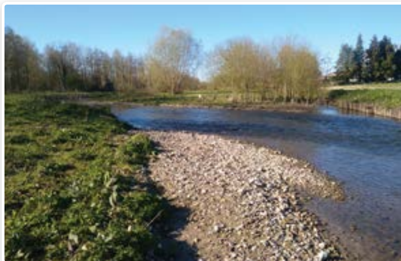
Zone de dépôt suite à la reprise du transit sédimentaire à la sortie du nouveau tracé
