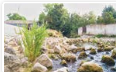
Rampe en enrochement, une solution pour restaurer la continuité écologique (Vincent Hanotin)
