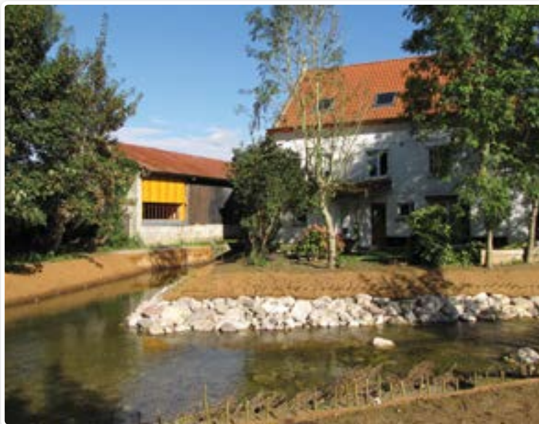
Difffluence vers l'aval, après travaux
