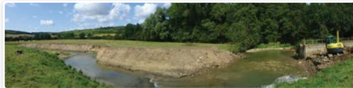
Photo panoramique du site après travaux (FDAAPPMA62)
