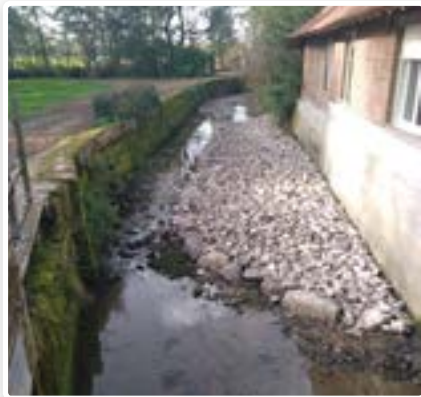
Amas de cailloux disposé sur le bras gauche, après travaux
