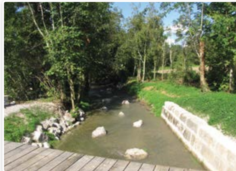
Vue du bras droit vers l'aval après travaux
