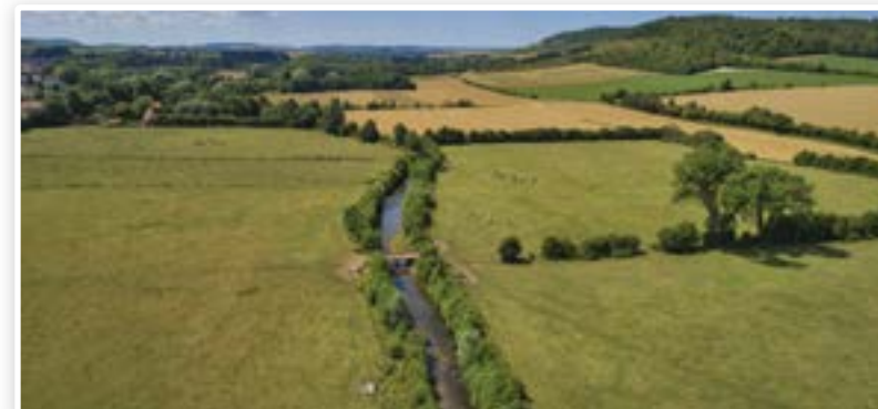
Bief* et ripisylve* restaurés à l'amont de l'ouvrage du moulin de Guémy à Tournehem-sur-la-Hem.
