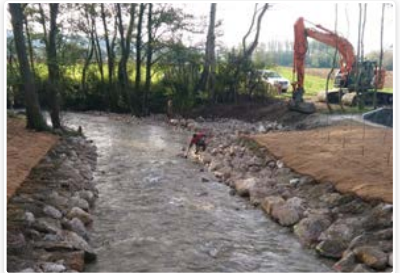
Vue du bras droit vers l'aval après travaux
