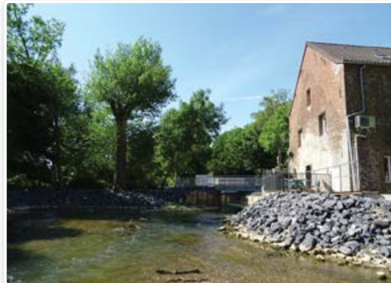
Ouvrage du Moulin bleu après effacement
