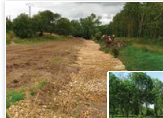
Nouveau lit de rivière avant la mise en eau
