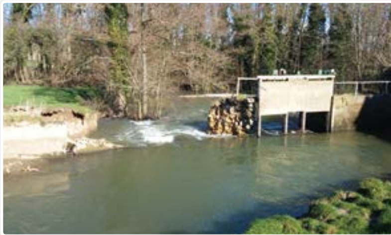
Ouvrage du déversoir vers l'aval avant travaux
