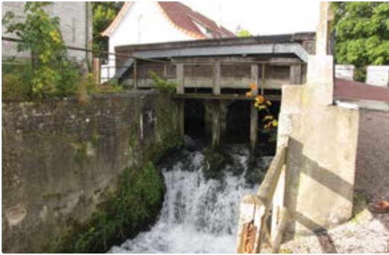
Ouvrage du bras droit avant travaux
